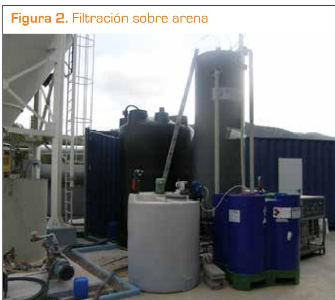
Figura 2. Filtración sobre arena
