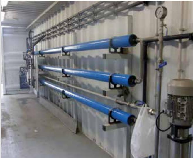
El resultado de sumar la presión osmótica, la sobrepresión de producción y las pérdidas de carga de la instalación, es la presión de trabajo que debe proporcionar la bomba de alta presión.
