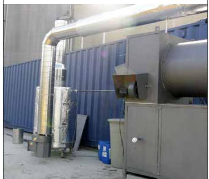
mediante dos boquillas pulverizadoras. Cada una de estas boquillas está situada en una línea independiente de la otra y aisladas mediante electroválvulas. Esta cámara está calentada por los gases depurados procedentes del horno de combustión de residuos. El agua se evapora de forma instantánea saliendo en forma de vapor por la chimenea del equipo, quedando las sales retenidas en el fondo de la cámara.
