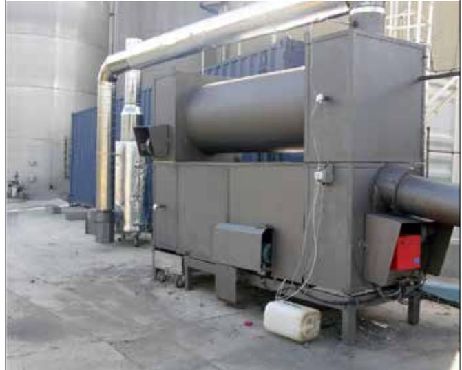
ratura que permita destruir los compuestos orgánicos que puedan estar presentes en los gases. La temperatura de funcionamiento de esta cámara se mantiene en un margen de entre 850 y 900 °C.
